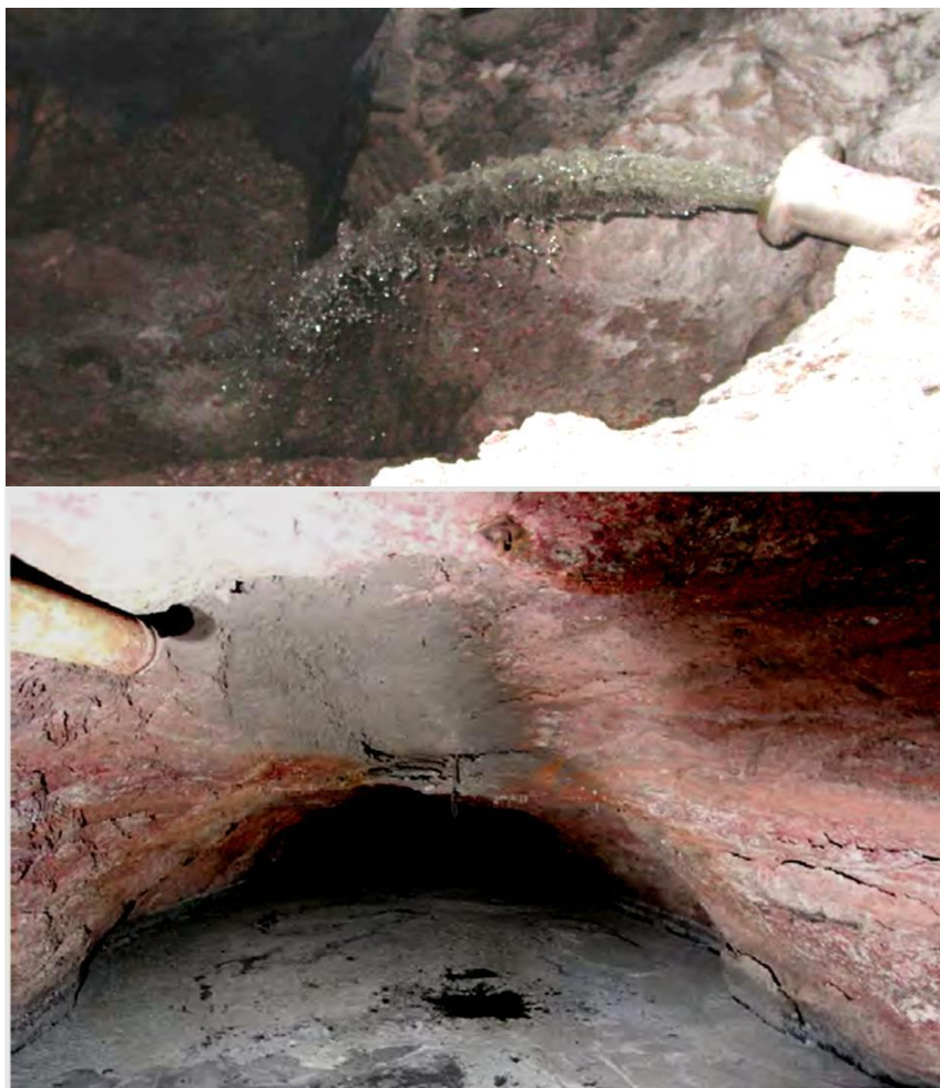
Рис. 4. Процесс гидравлической закладки в закладываемых камерах
