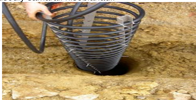
2-rasm. Vertikal geotermal issiqlik nasosi.
