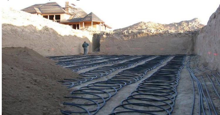
1-rasm. Gorizontol geotermal issiqlik nasosi.
